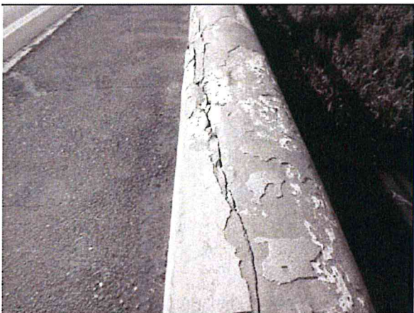
Poruchy betonu madla zábradlí vlevo
