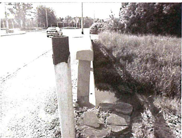
Vykloněné zábradlí na konci vlevo
