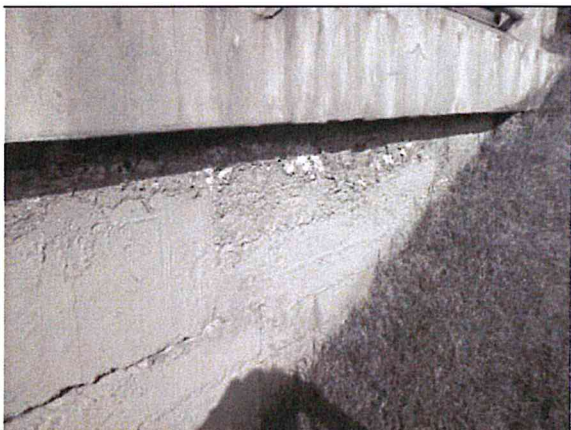
Výkvěty na betonu křídla na konci mostu vpravo
